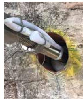
La necessità di realizzare un ancoraggio efficace e al contempo di evitare la dispersione della malta iniettata nel nucleo del pilastro ha portato all'utilizzo di **ancoraggi a iniezione controllata con calza**.
