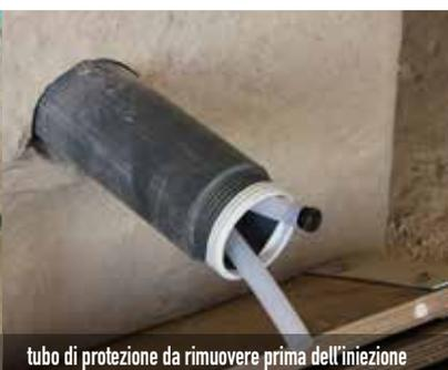
tubo di protezione da rimuovere prima dell'iniezione
