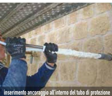
inserimento ancoraggio all'interno del tubo di protezione
